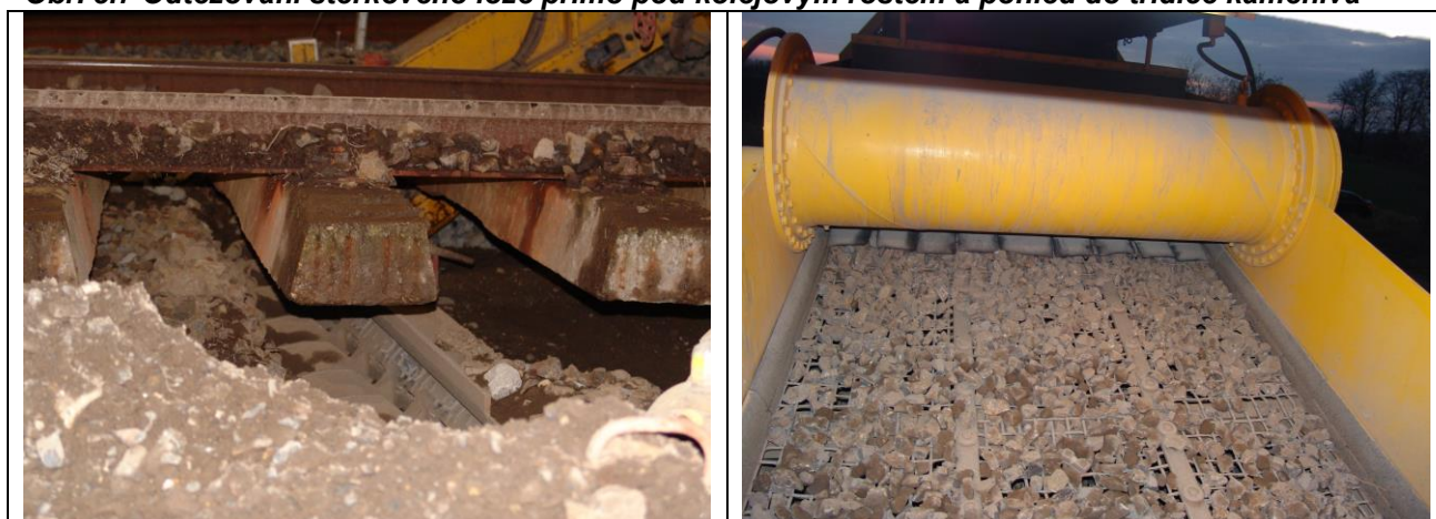
Obr. č.7 Odtěžování štěrkového lože přímo pod kolejovým roštem a pohled do třídiče kameniva
